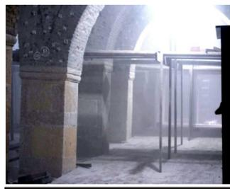
Уже выполнены работы по реставрации швов южной ограды, укрепление кладки исторической части южной ограды методом инъектирования, инъектирование кладки в районе перемычек дверных проемов внутри мечети. Генподрядчиком является АО «ТСНРУ».
