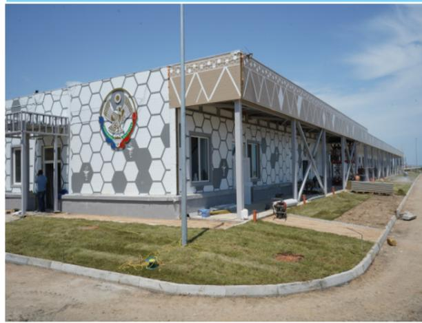
В настоящее время военные строители асфальтируют подъездные пути к будущему многофункциональному медицинскому центру и выполняют работы по внутренней отделке, установке сантехнических приборов и устройств, оклейке аппликации, монтажу подвесного каркаса потолка, озеленения прилегающей территории. Также оборудуется специальная локальная очистная система канализации, то есть в море будет сбрасываться уже очищенная вода.
