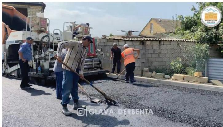
На сегодняшний день полностью завершена укладка инженерных сетей, подготовлено дорожное основание для последующего асфальтирования. Рабочие приступили к укладке первого слоя асфальта, параллельно ведутся работы по установке столбов уличного освеще-
