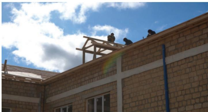
укладке кровли, накрыли пленкой последний участок, на днях будем покрывать профнастилом. Сейчас работы в основном ведутся по стяжке полов, а также по усилению плит перекрытия. На 80 про-
