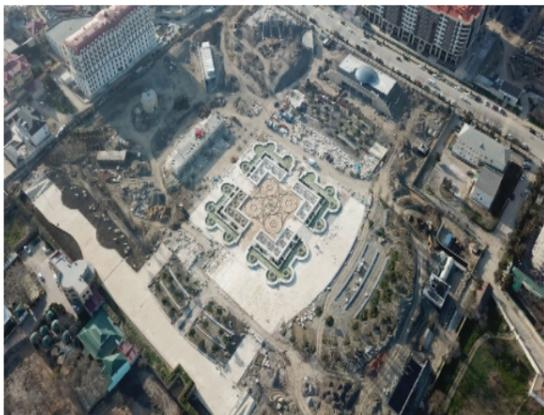
На объекте завершено устройство бетонной площадки детского городка, вокруг которого сформирована основная часть холма, уложены электрические кабели для архитектурного освещения. Также установлены скальные камни по рельефу холма вокруг детского городка и вдоль пешеходных тропинок.
